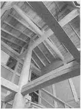
▶丸太柱を中心にした木組み
