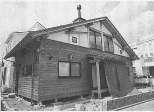
▶内外壁を真壁で仕上げた。足元は石場建て
