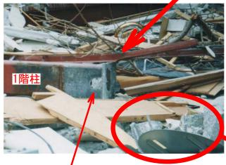
柱を切り欠いてアンカーボルト を納めているピン柱脚。
