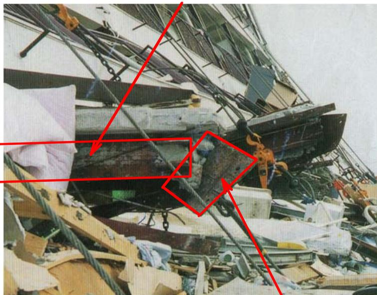
柱にリブプレートが付いているが、柱が変形性能を発揮する前に溶接部で破断している。
